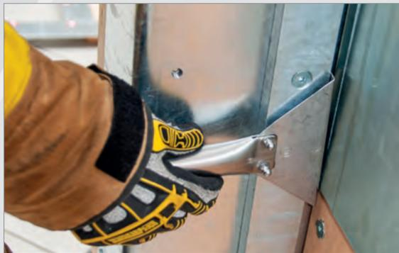
• Durch Anbau eines Türfalz ist auch das zerstörungsfreie Öffnen mit Türfallenblech oder ähnlichen Werkzeugen möglich.
